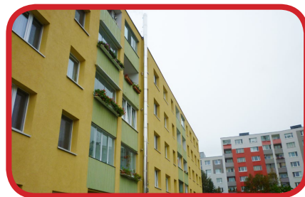
Domová kotolňa na Haanovej 37.
