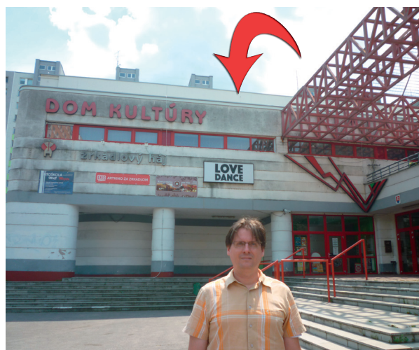
Opravená strecha kultúrneho domu.
