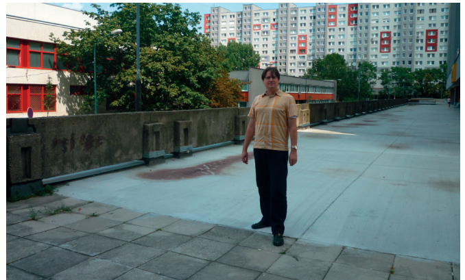
Opravená pochôdza časť terasy na Rovniankovej ulici.
